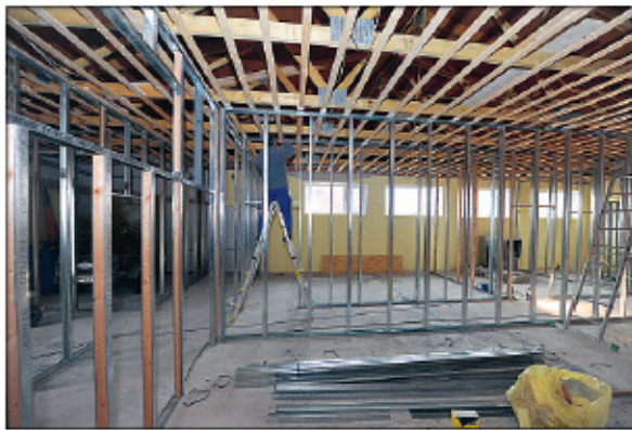
Hier müssen noch die Wände gezogen werden.
